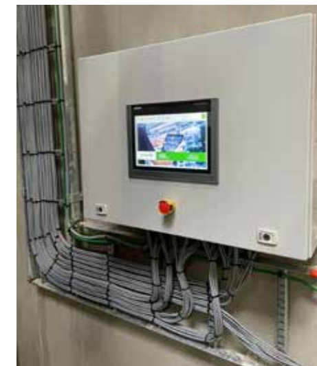
Een complexe sturing, maar voor de operator achter de knoppen is alles kinderspel. Hij moet enkel de receptuur kiezen, alle parameters worden dan automatisch ingesteld.
